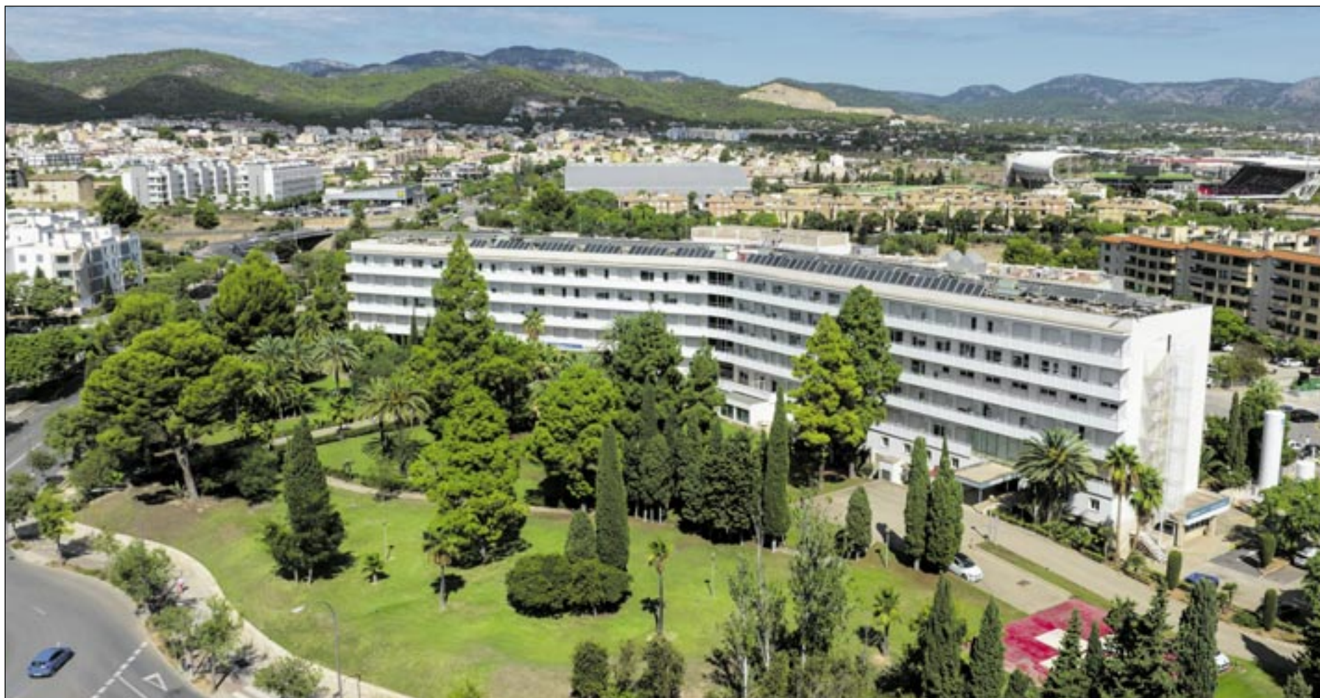
Vista aérea del Hospital Universitario Juaneda Miramar.
