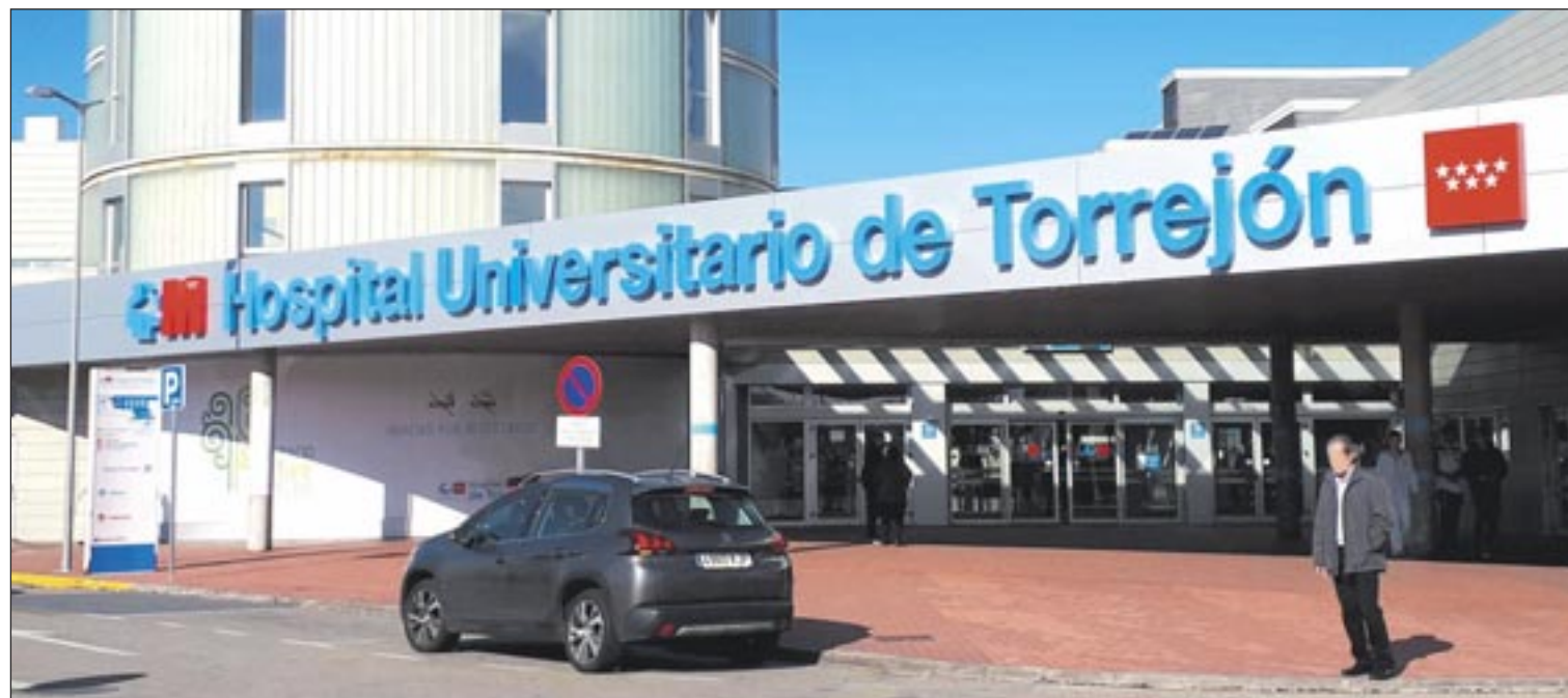
Hospital de Torrejón de Ardoz.
