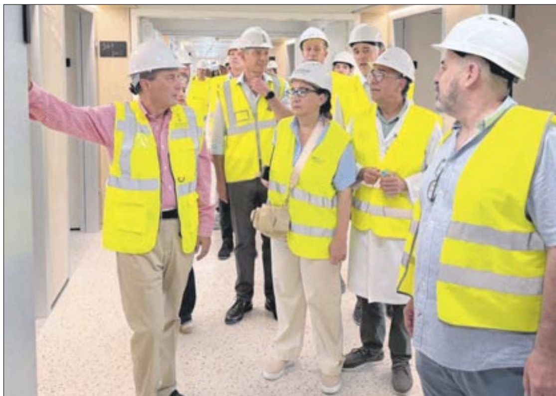
El conseller, revisando las obras.
