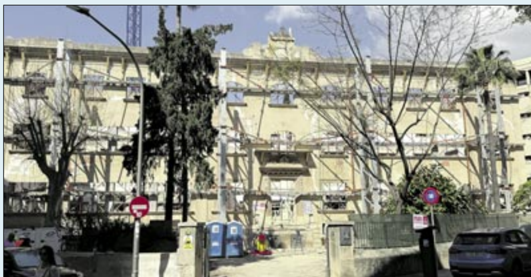
Vista actual de las obras de reforma.
