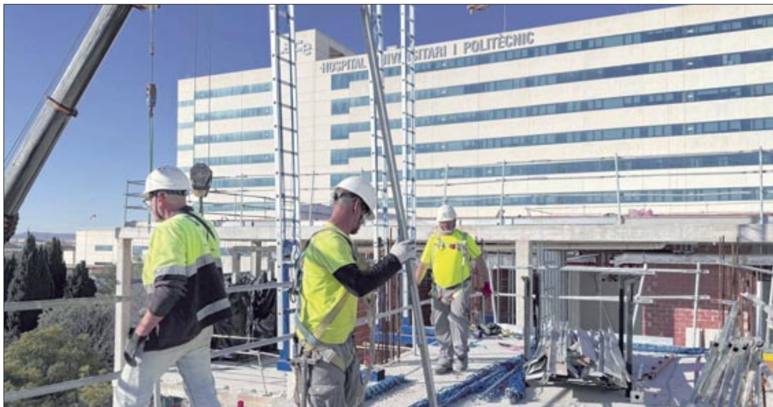
Imagen de las obras llevadas a cabo.
