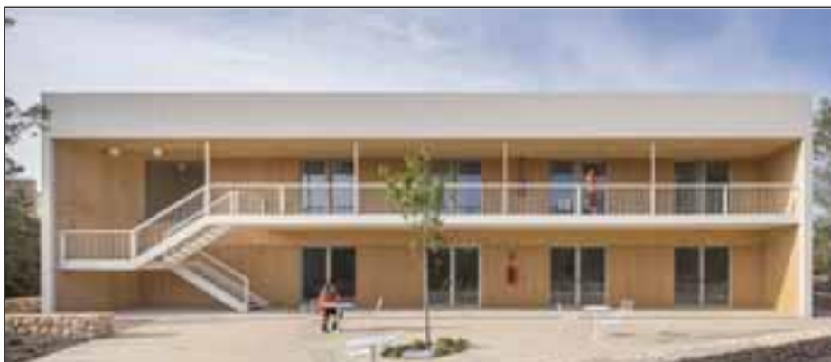
Instalaciones de la base.
