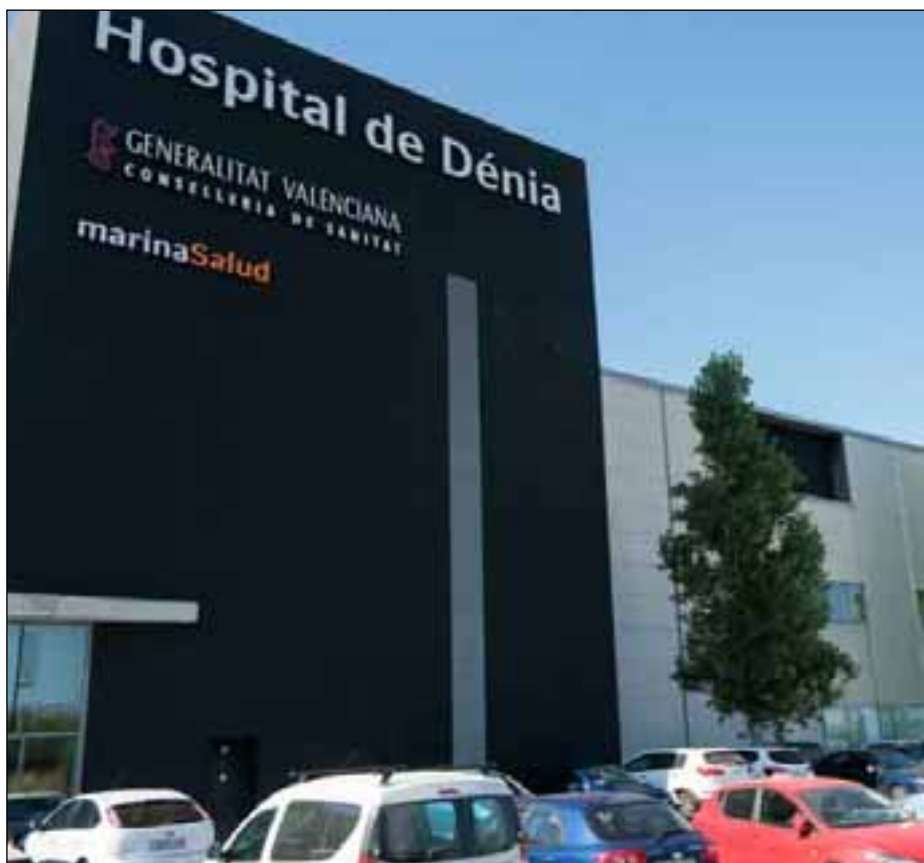
Hospital de Dénia.
