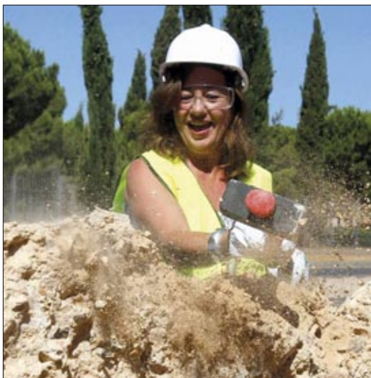
Francina Armengol, golpeando con la maza el muro.
