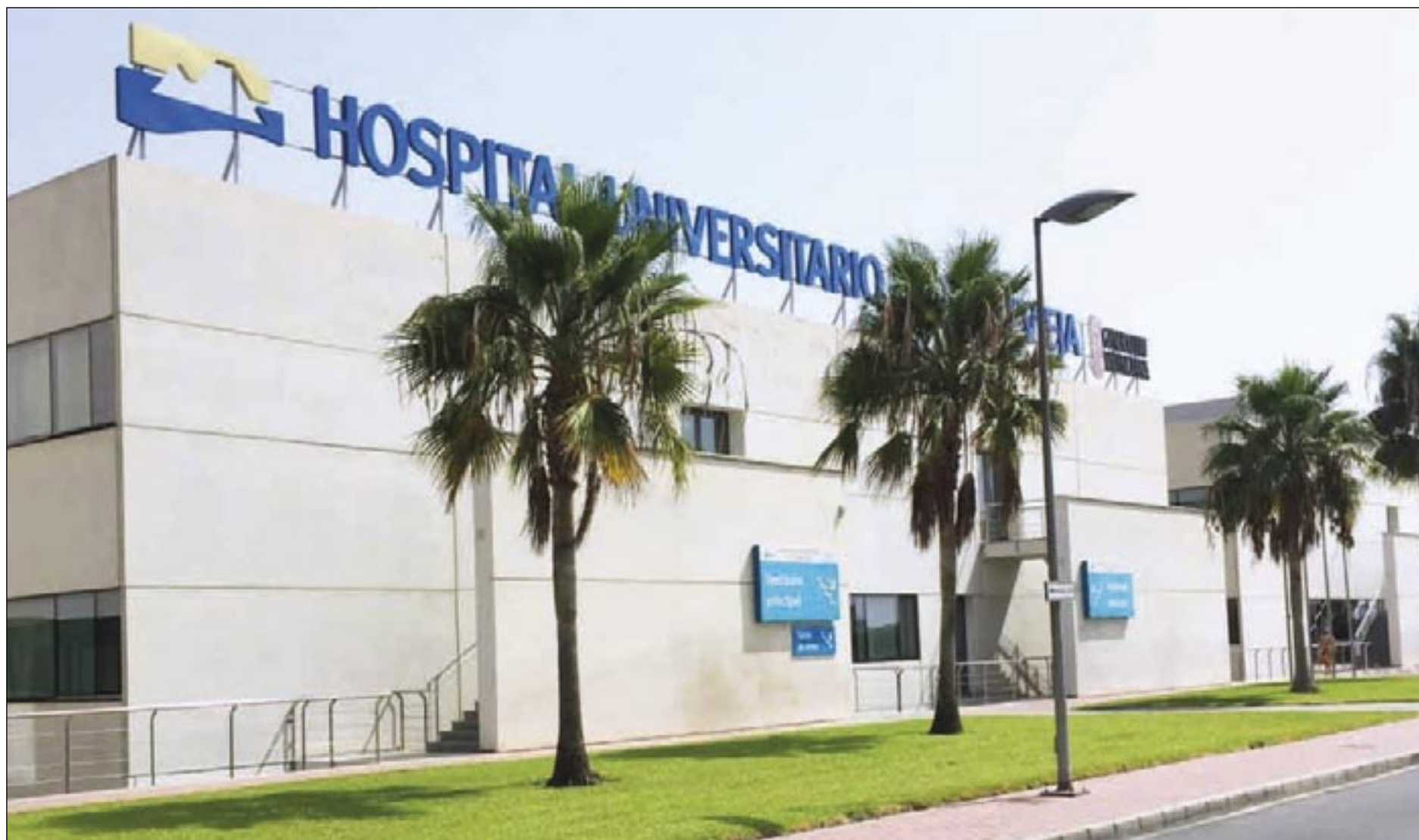
Vista general del Hospital de Torrevieja.
