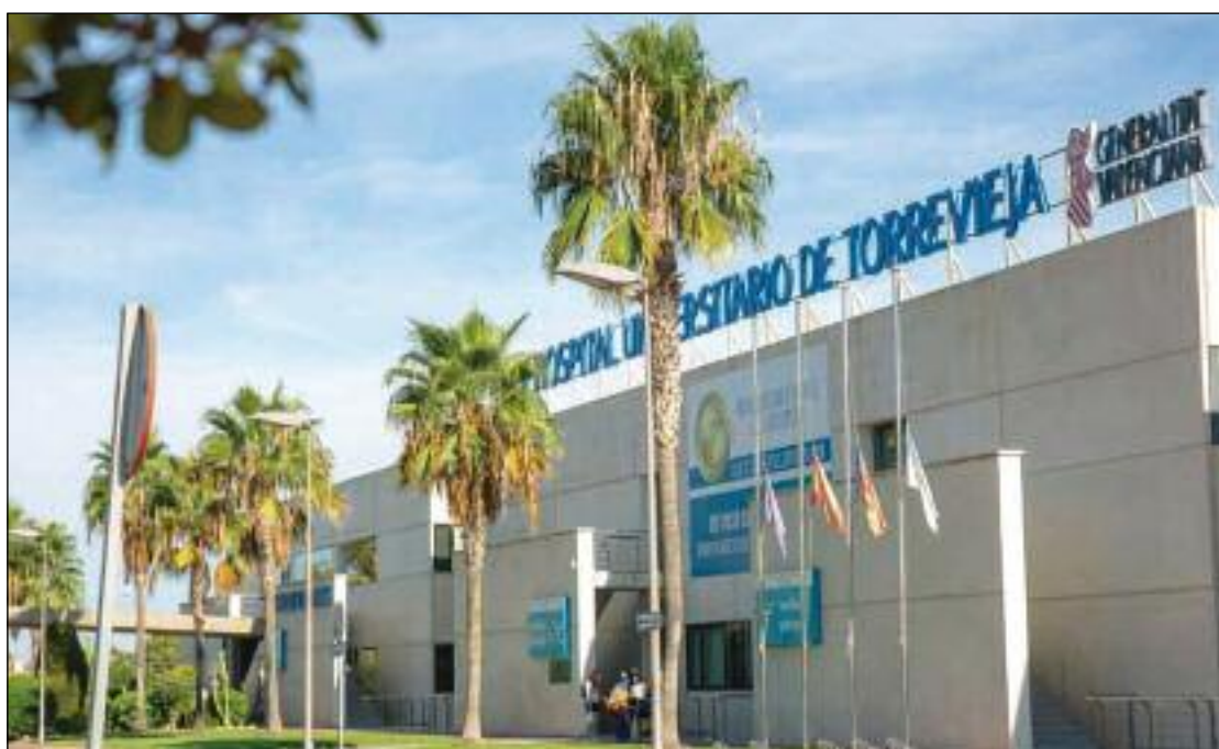
Vista general del Hospital de Torrevieja.
