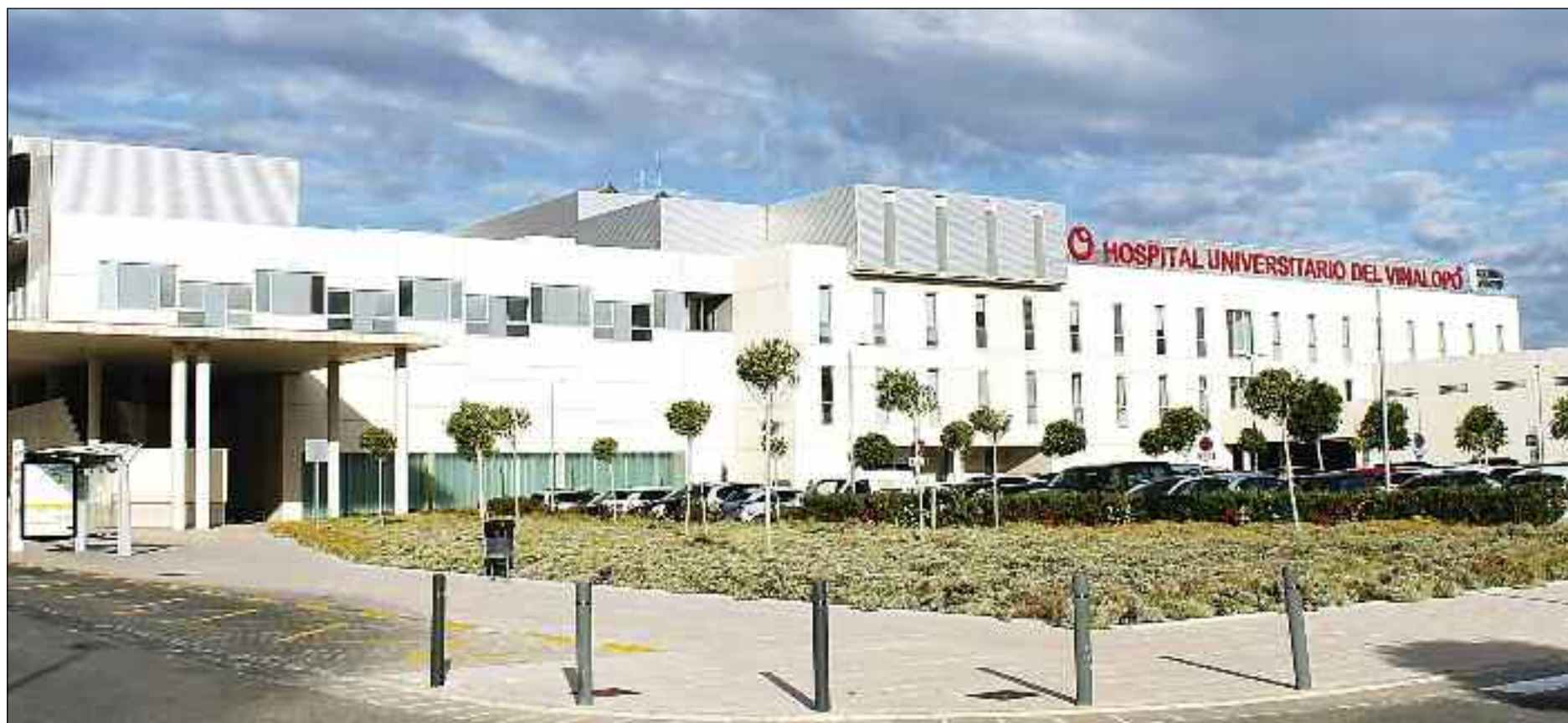
Vista general del Hospital de Torrevieja.
