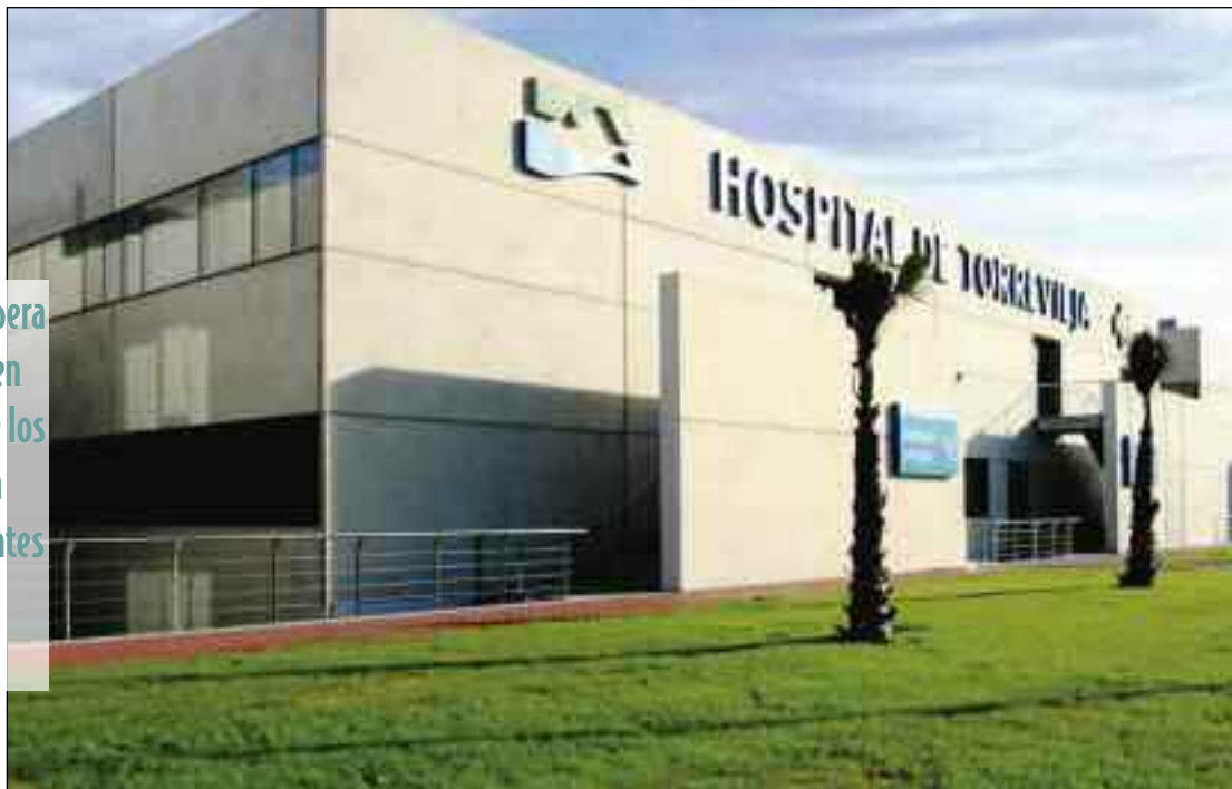
Vista general del Hospital de Torrevieja.
