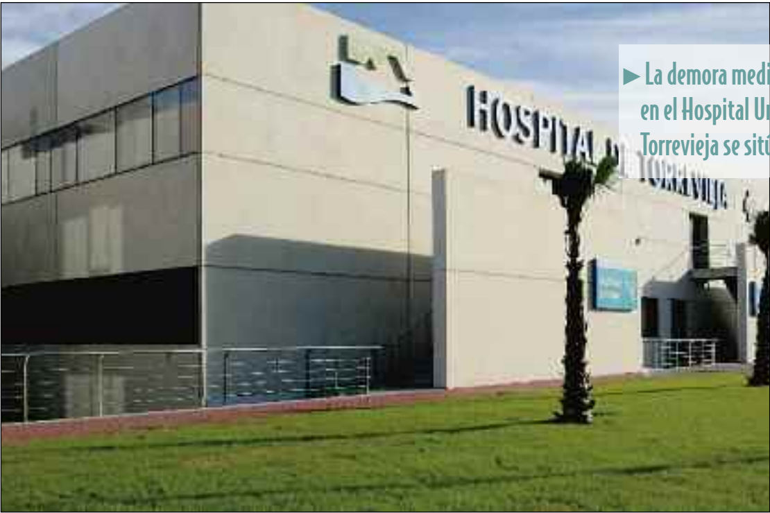
Vista general del Hospital de Torrevieja.
