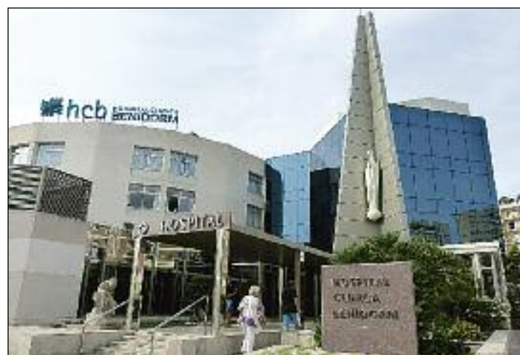
Vista general de la fachada de Hospital Clínica Benidorm.
