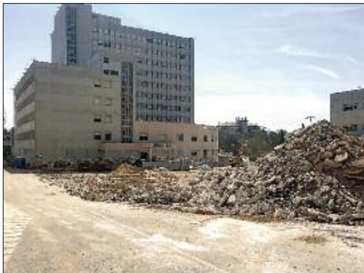
Ya se ha empezado a demoler.
