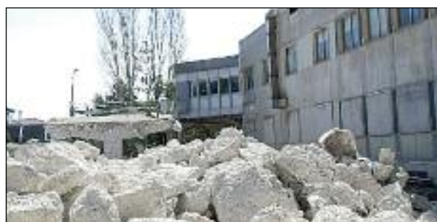
Iniciada la demolición del Hospital de Son Dureta
