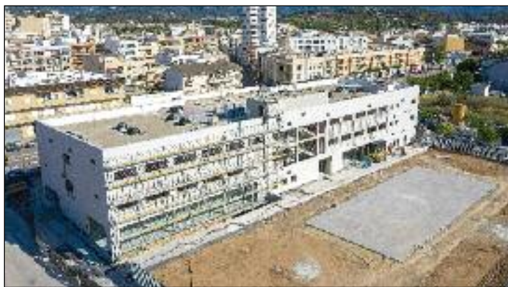
Vista aérea del estado de las obras.
