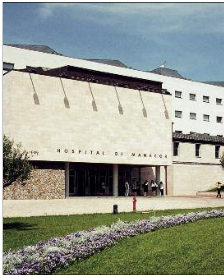
Vista exterior del Hospital de Manacor.
