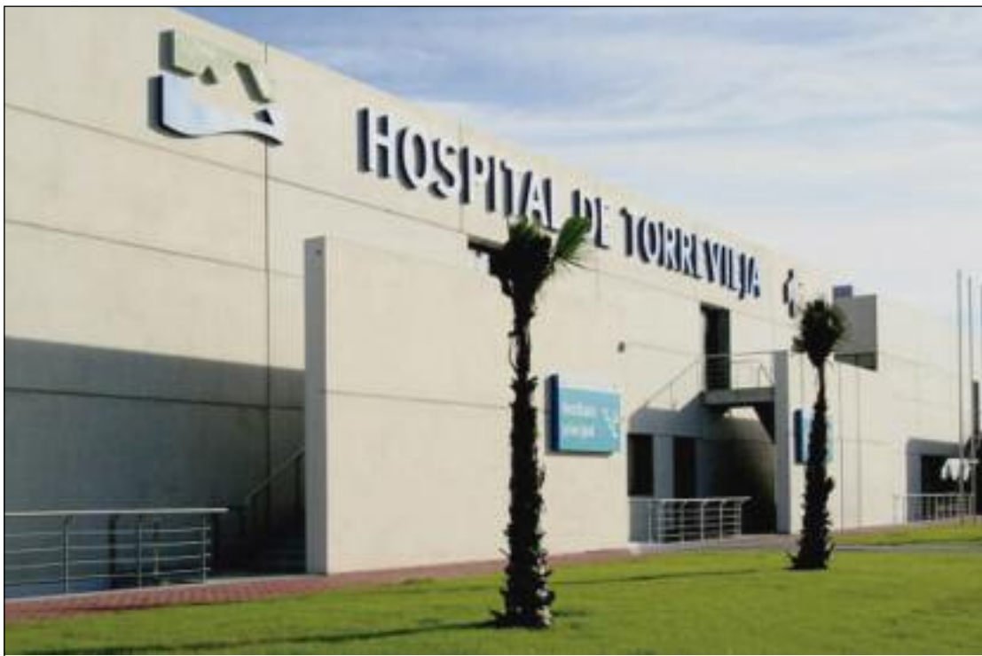
Imagen del Hospital de Torrevieja.
