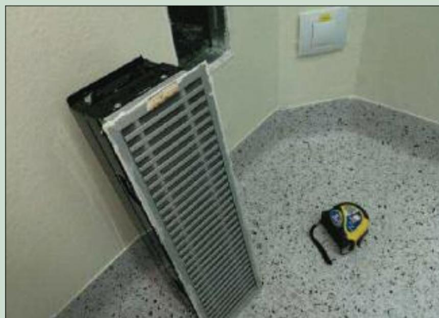
**15 de junio:** se detecta una incorrecta embocadura de las rejillas de extracción de los tabiques interiores. Los conductos de extracción no están correctamente encuadrados con el hueco de las rejillas. La concesionaria efectúa injertos de conducto de chapa galvanizada para sellar los huecos.
