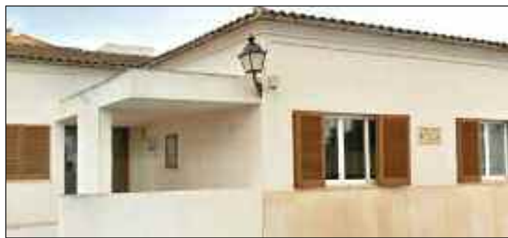
Vista exterior del centro de salud de Vilafranca.
